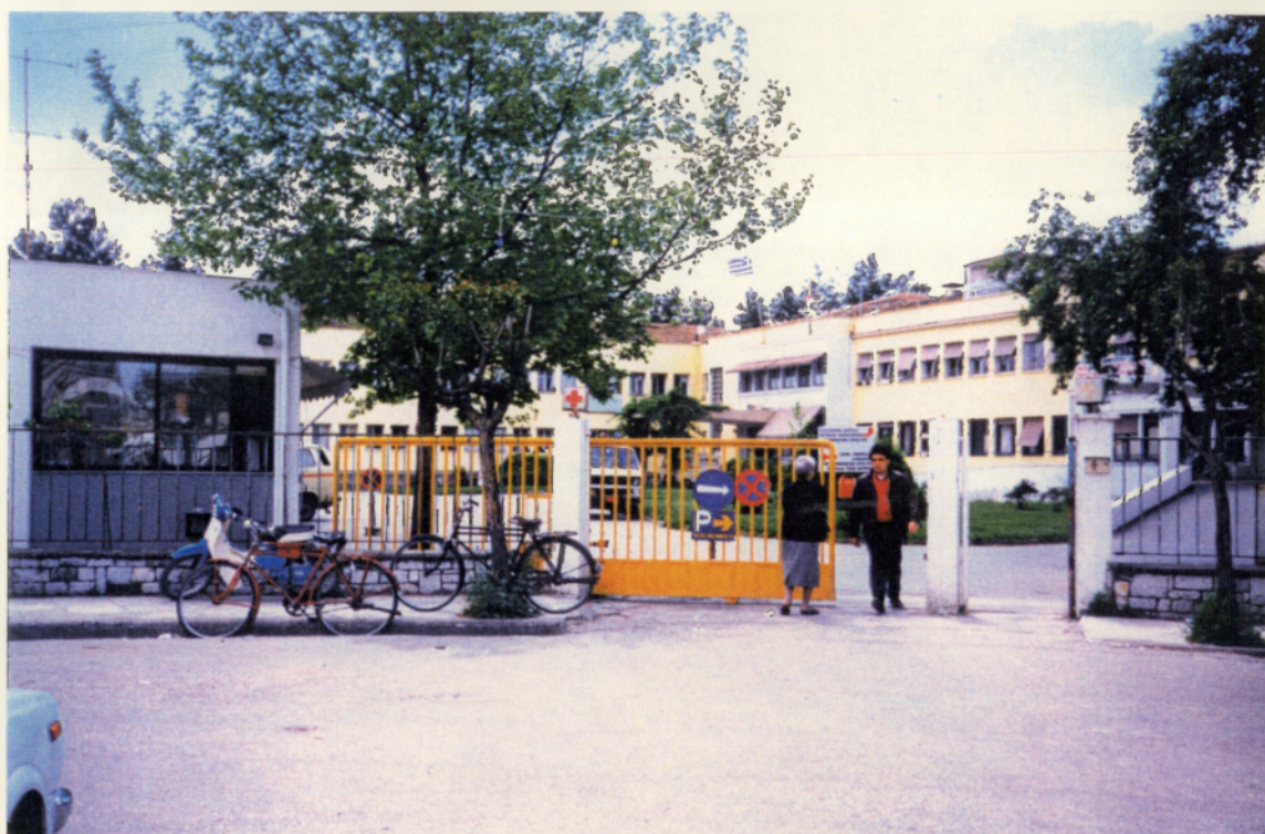
ΦΩΤ. 2: ΕΙΣΟΔΟΣ Γ.Ν.Ν. ΤΡΙΚΑΛΩΝ
