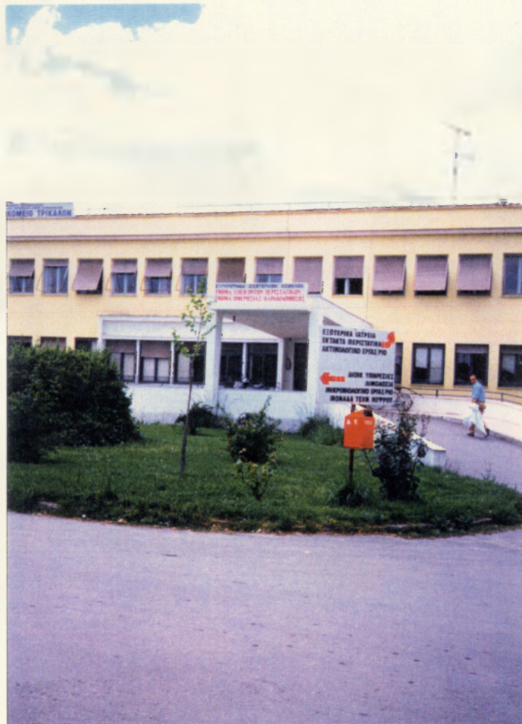
ΦΩΤ. 4: ΕΙΣΟΔΟΣ ΠΡΩΤΩΝ ΒΟΗΘΕΙΩΝ
