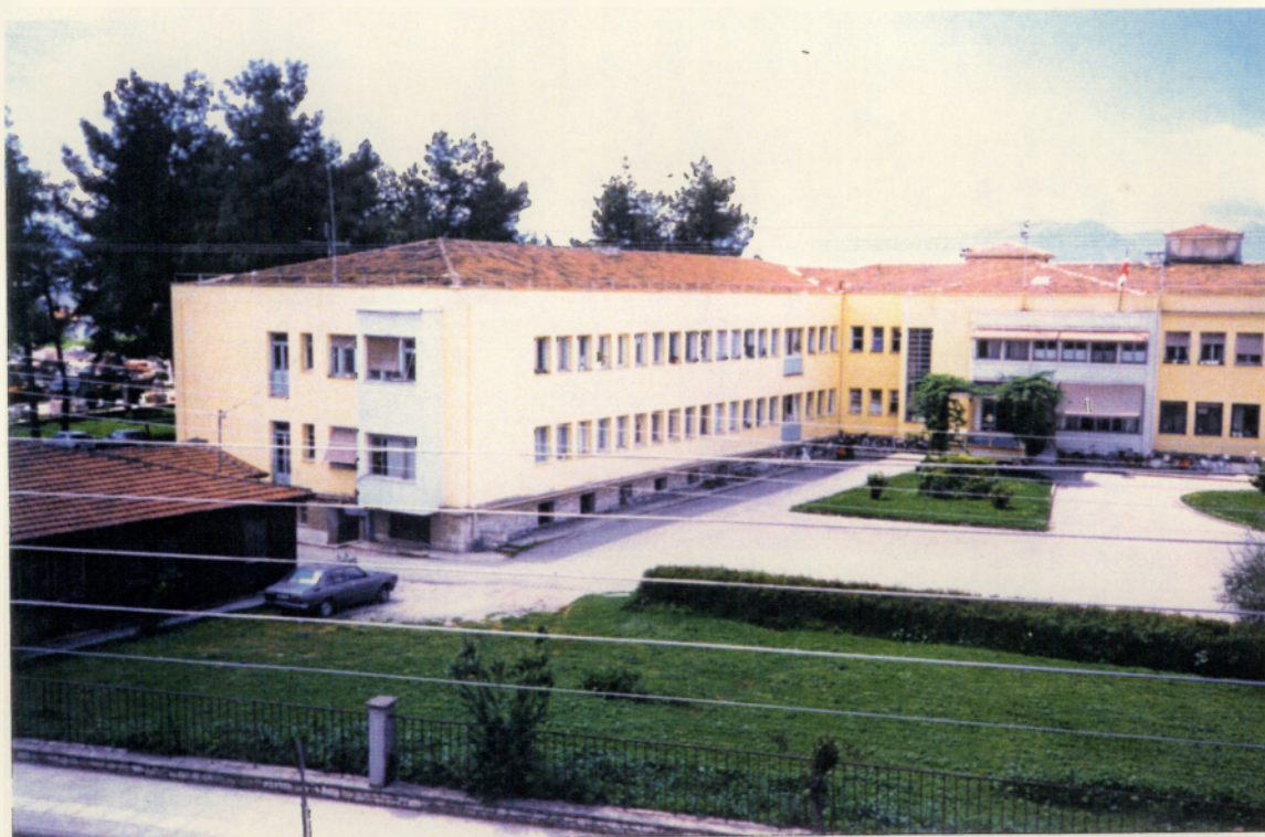
ΦΩΤ. 6: ΘΕΣΗ ΛΥΟΜΕΝΟΥ ΚΤΙΡΙΟΥ ΣΕ ΣΧΕΣΗ ΜΕ ΤΟ ΝΟΣΟΚΟΜΕΙΟ
