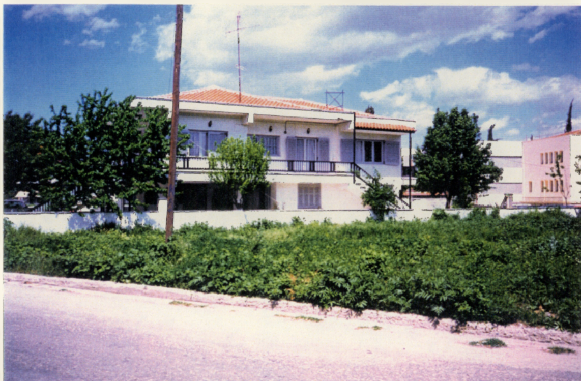
ΦΩΤ. 7: ΔΙΟΡΟΦΟ ΚΤΙΡΙΟ ΔΙΟΙΚΗΤΙΚΗΣ ΥΠΗΡΕΣΙΑΣ ΚΑΙ ΜΟΝΑΔΑΣ ΠΡΟΛΗΨΗΣ ΜΕΣΟΓΕΙΑΚΗΣ ΑΝΑΙΜΙΑΣ
