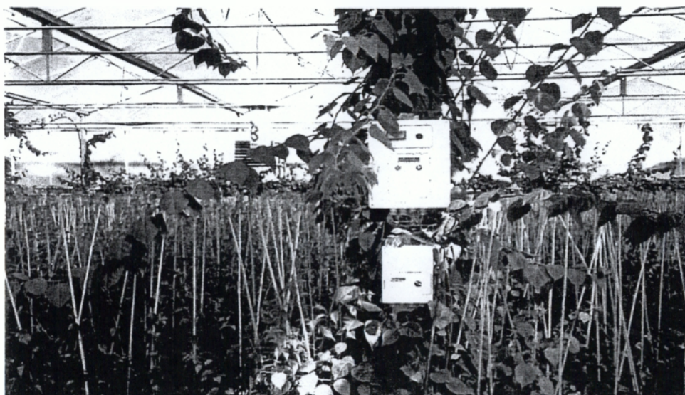
Εικόνα 6. Ηλεκτρονικό σύστημα καταγραφής και ρύθμισης μερικών παραγόντων περιβάλλοντος του θερμοκηπίου. α)θερμοστάτης β)κλίση παραθύρων γ)ρυθμιστής βροχής δ)ρυθμιστής ανέμου
