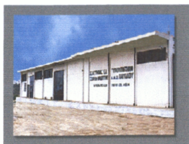
Εικ.19 "Σπαστήρας Ν. Καβάλας (κτήριο)"
