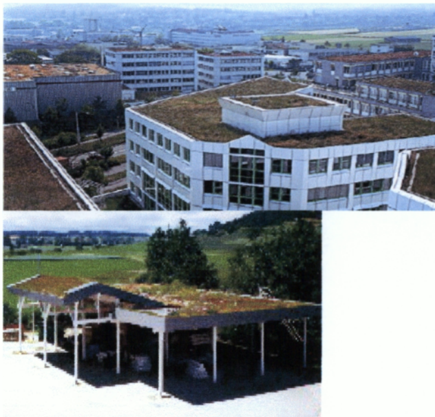
εικόνα 1,2 εκτενής τύπος roof garden
