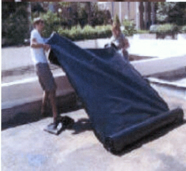
ΕΙΚΟΝΑ 24,25 Στρώμα μόνωσης των επιφανειών των στεγών
