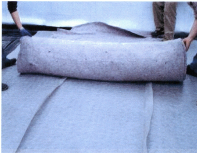
εικόνα 8. Σύστημα στεγανοποίησης
