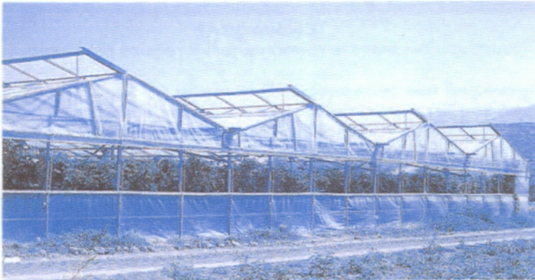
Εικ. 2.3 Παθητικός εξαερισμός με συνεχόμενα παράθυρα οροφής και πλευρικά
