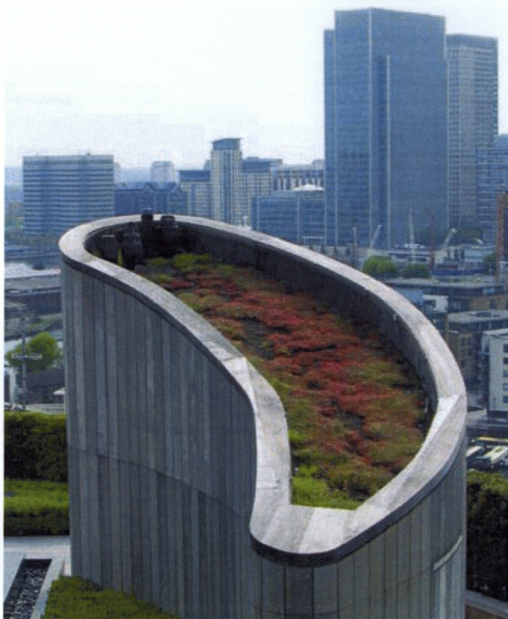
Φωτό 1.3, Πράσινη στέγη στο Λονδίνο
