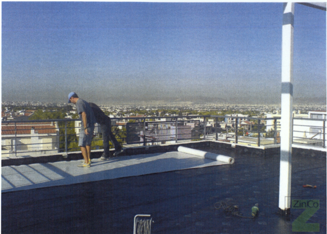
Φώτο 4.1, Στεγάνωση πράσινης στέγης
