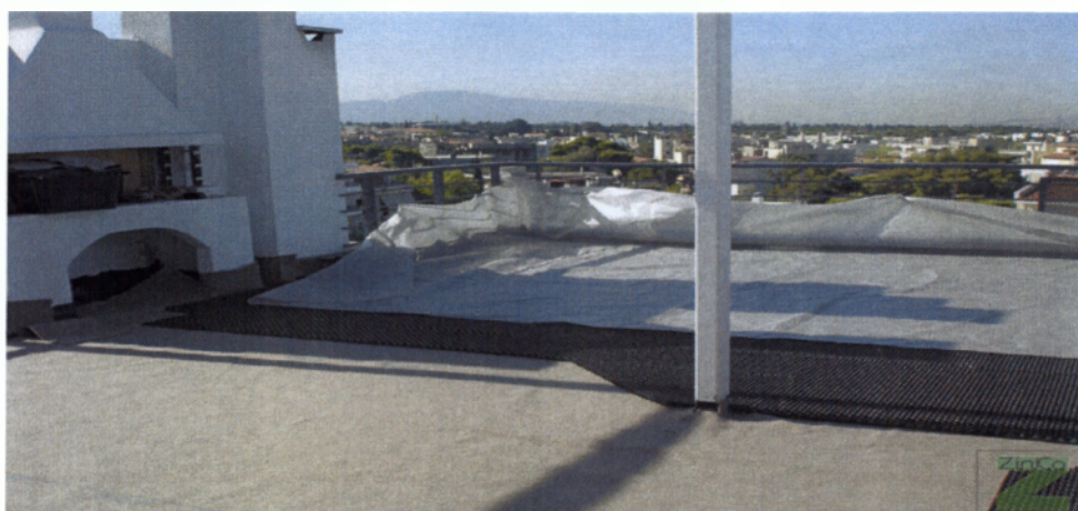
Φώτο 4.4 Διάστρωση διηθητικού φύλλου
