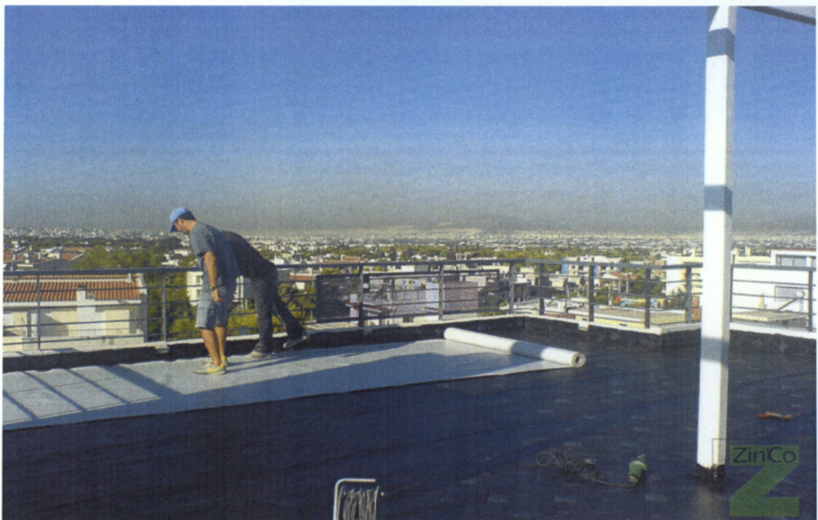
Φώτο 4.2, Διάστρωση υποστρώματος
