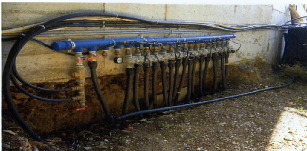
Εικόνα 3: Τοποθέτηση αρδευτικού συστήματος
