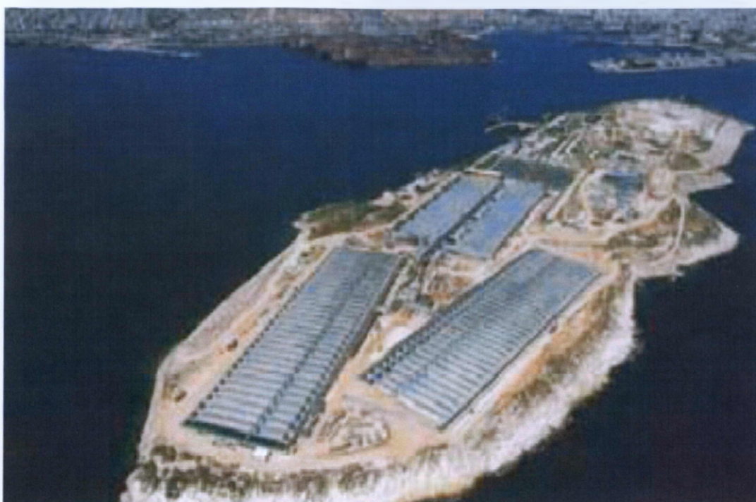
Εικόνα 6: Εγκατάσταση επεξεργασίας λυμάτων (ΕΕΛ) στην Ψυτάλλεια, Ελλάδα (ΕΥΔΑΠ Α.Ε.)
