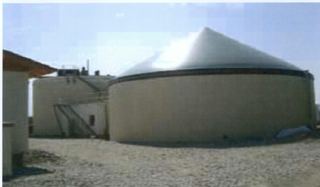
Εικόνα 4: Κατακόρυφη μονάδα βιοαερίου στη Γερμανία που κατασκευάστηκε το 2005 για τη χώνευση ενεργειακών καλλιεργειών (Krieg & Fisher, 2008)
