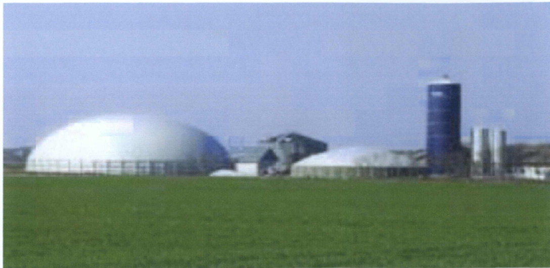
Εικόνα 2: Μονάδα βιοαερίου κλίμακας αγροκτήματος στη Δανία, για συγχώνευση υδαρών κοπριών και ενεργειακών καλλιεργειών (GROENGAS A/S)
