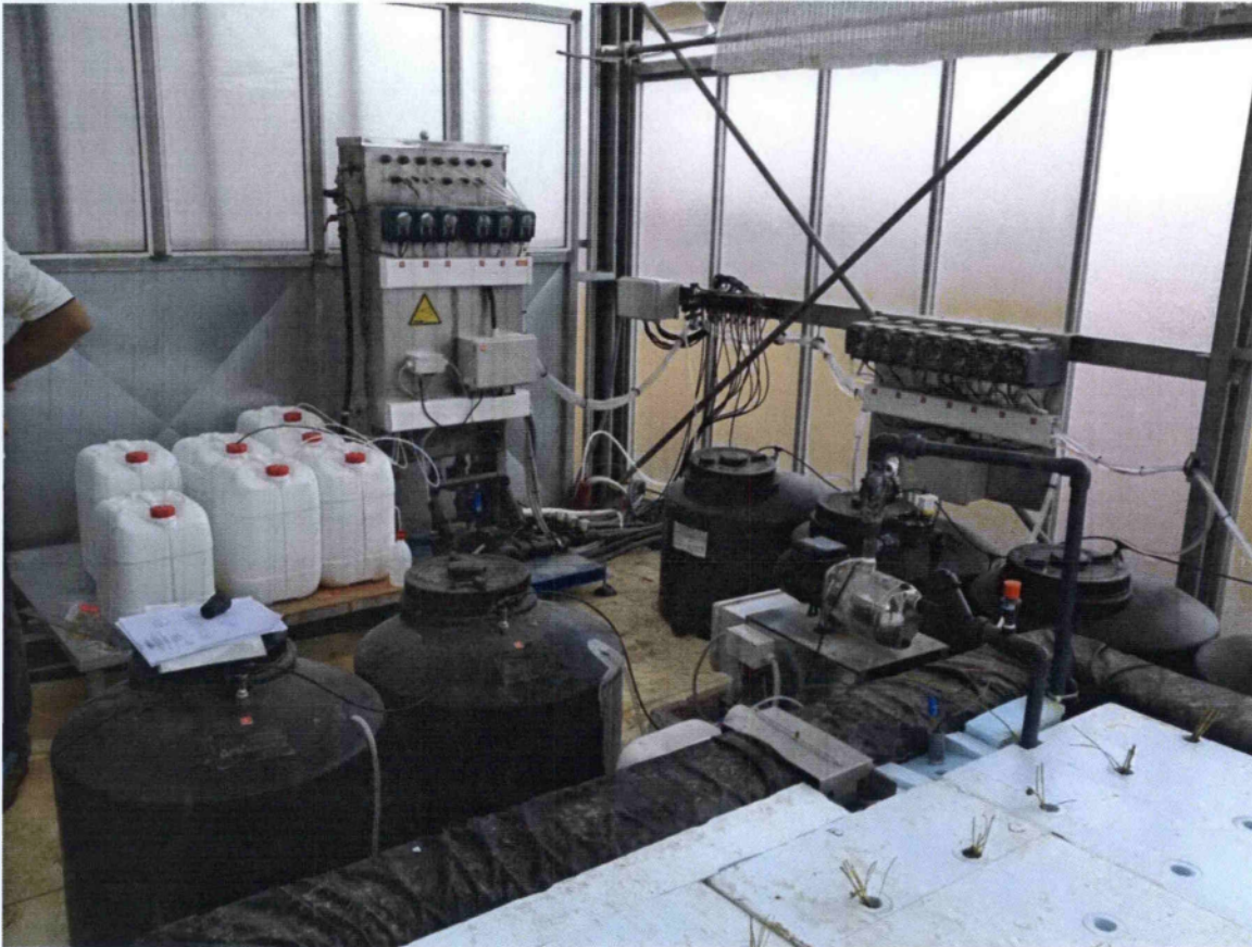
Εικόνα 7.3 Κεφαλή υδρολίπανσης και δοχεία πυκνών λιπασμάτων
