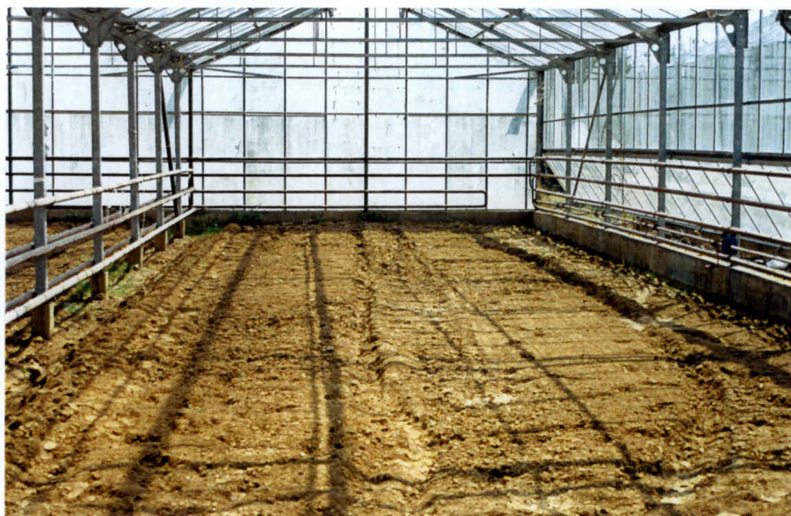
Φώτο 2.: Ισοπέδωση εδάφους στο θερμοκήπιο.
