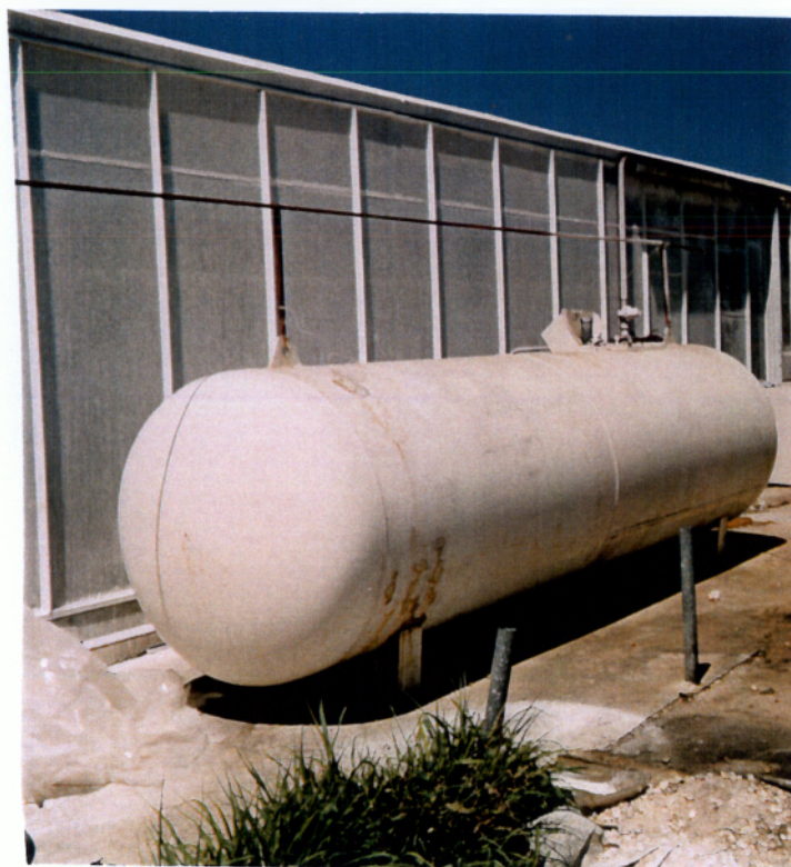
Φώτο 7.: Δεξαμενές πετρελαίου 7m 3 η κάθε μία. Φώτο 8.: Δεξαμενή (βυτίο) υγραερίου 15m 3
