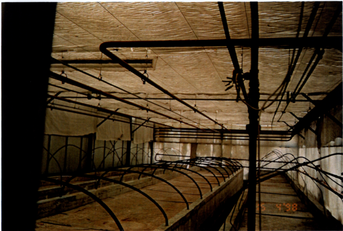
Φώτο 2.: Χώρος ριζωτηρίου με τσιμεντένια θερμαινόμενα τραπέζια.
