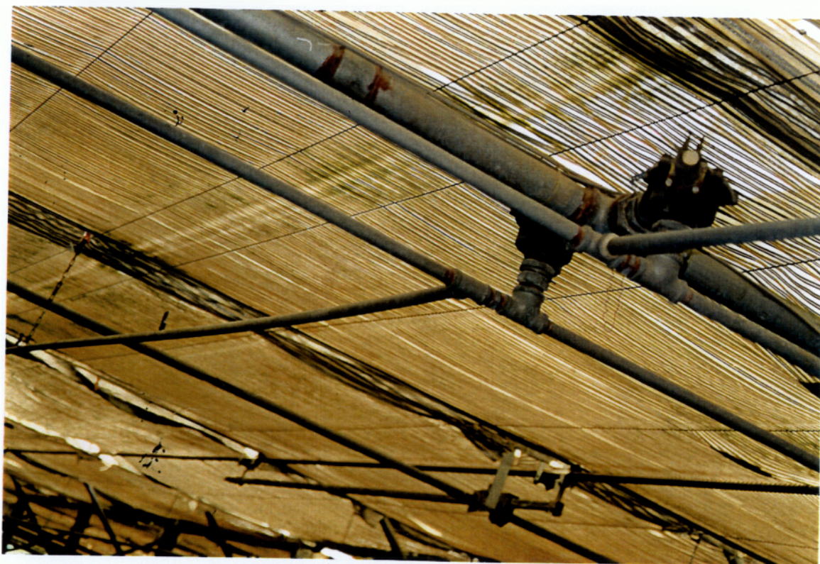
Φώτο 9.: Σωληνώσεις - μπεκ συστήματος υδρονέφωσης.
