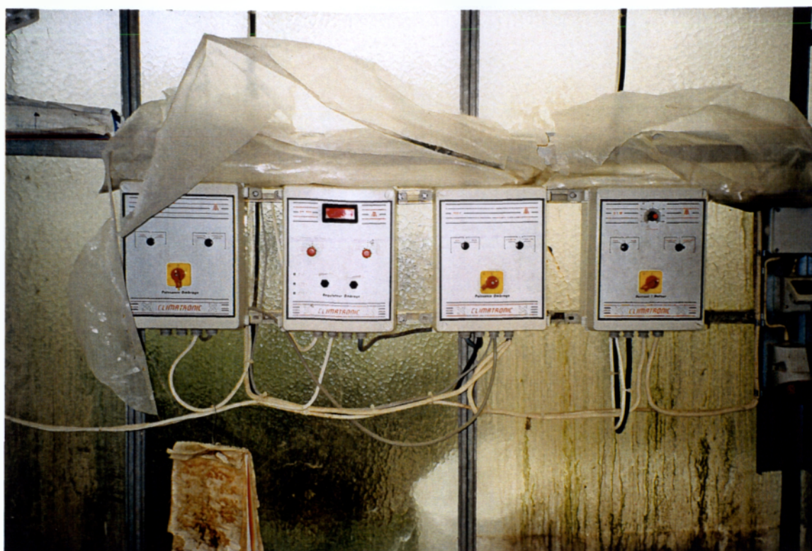
Φώτο 12.: Χειροκίνητα συστήματα για το άνοιγμα - κλείσιμο κουρτινών και παραθύρων (Με δυνατότητα αυτοματοποίησης).
