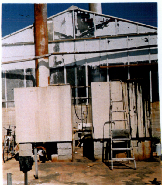
Φώτο 7.: Δεξαμενές πετρελαίου 7m 3 η κάθε μία. Φώτο 8.: Δεξαμενή (βυτίο) υγραερίου 15m 3
