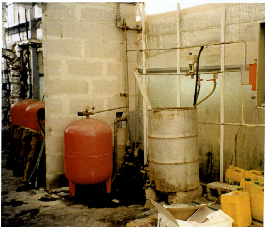
Φώτο 10.: Σύστημα άρδευσης: αριστερά δοχείο με αέρα υπό πίεση που δίνει πίεση στο νερό όταν αυτή του δικτύου δεν είναι αρκετή.
