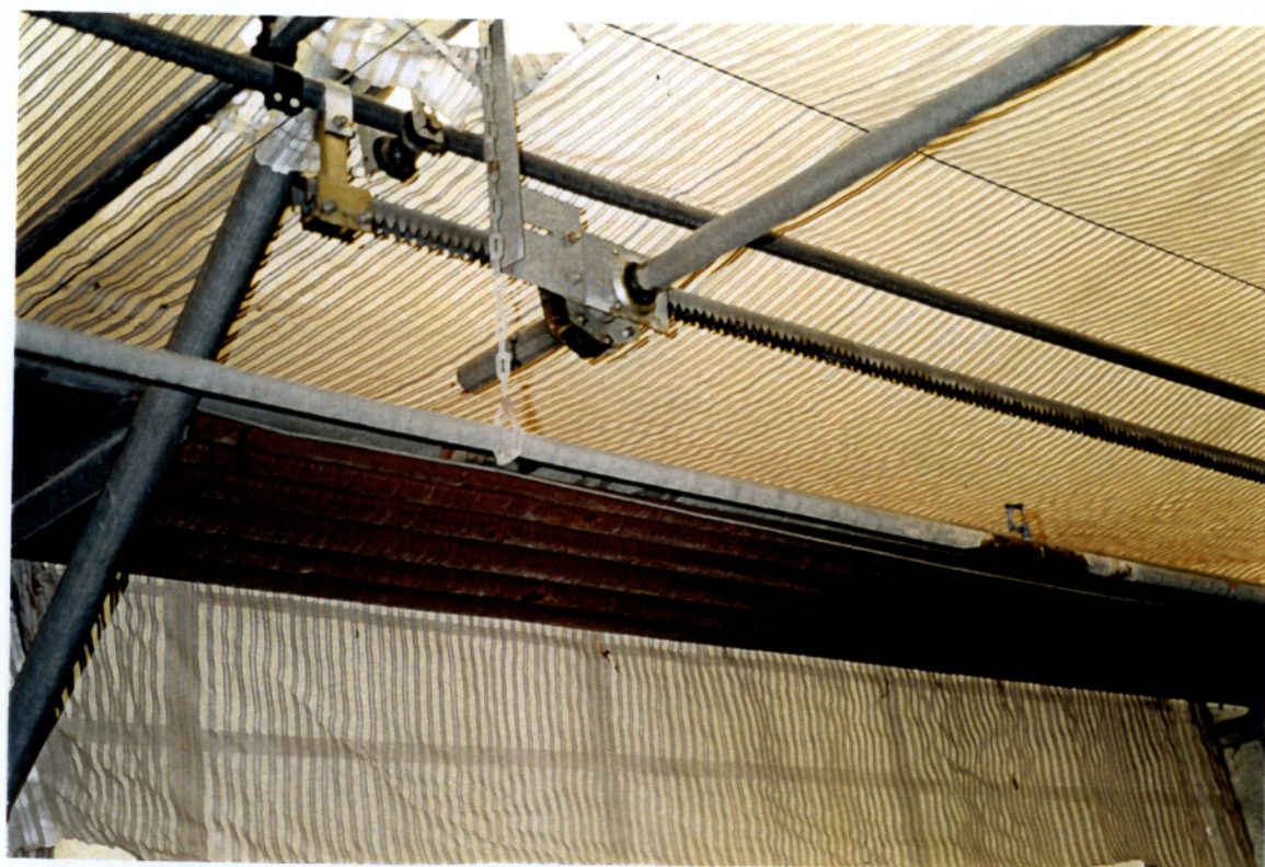
Φώτο 13.: Οδοντωτοί βραχίονες για το άνοιγμα και κλείσιμο κουρτινών. (Με δυνατότητα αυτοματοποίησης).
