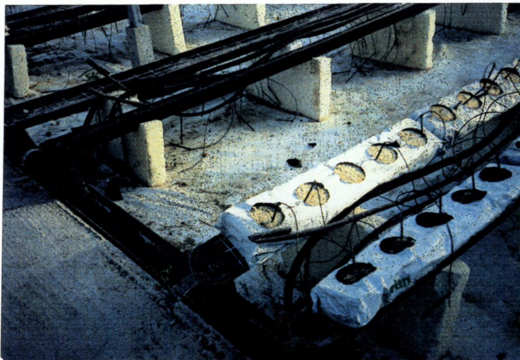
Εικ. 7 Πλάκες ανάπτυξης πετροβάμβακα Grodan τοποθετημένες στην τελική τους θέση
