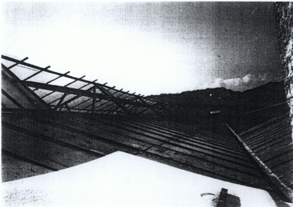
Εικ. 1.2: Θερμοκήπιο με φυσικό αερισμό οροφής
