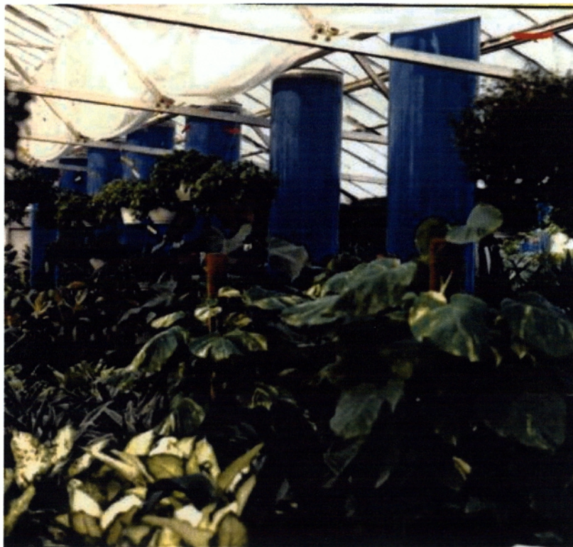
Σχήμα 4.2.2.α. Σωλήνες πολυαιθυλενίου γεμάτοι νερό για παθητική συλλογή και απόδοση της ηλιακής ενέργειας.
