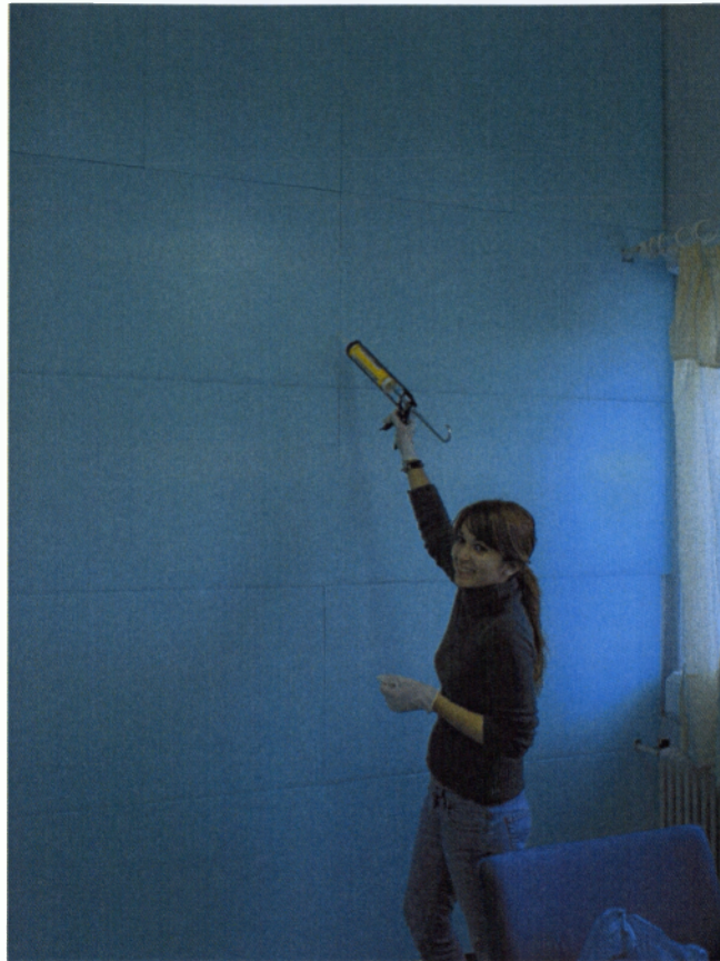
Εικ. 3 Τοποθέτηση φύλλων εξηλασμένης πολυστερίνης στον ενδιάμεσο τοίχο των δύο γραφείων
