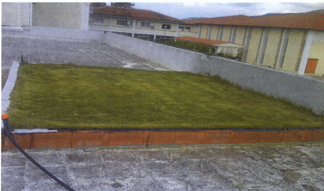
Εικ. 1 Η κατασκευή του ταρατσόκηπου στην ταράτσα του κτιρίου
