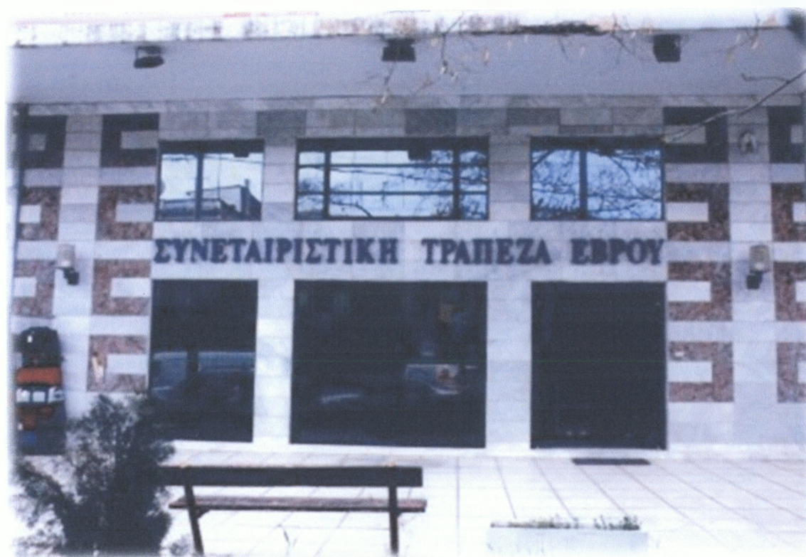
Εικόνα 2.4. Κατάστημα Συνεταιριστικής Τράπεζας Έβρου
