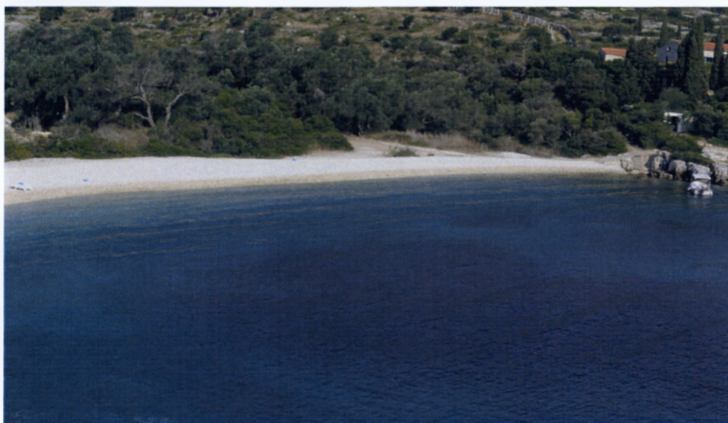
Εικόνα 15: Η παραλία της Κακής Λαγκάδας απ' όπου γίνεται η υδροληψία του θαλασσινού νερού για την μονάδα αφαλάτωσης.
