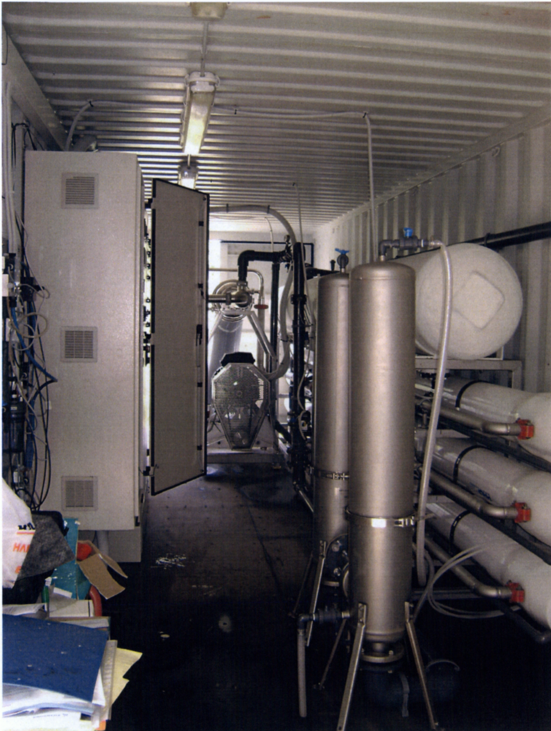
Εικόνα 14: Το εσωτερικό της μονάδας αφαλάτωσης της Κακίας Λαγκάδας στους Παξούς.
