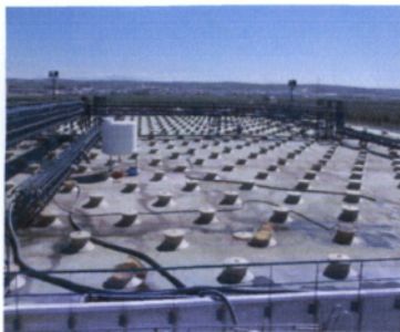
Εικ. 2.1: Υπόγειες δεξαμενές ζύμωσης
