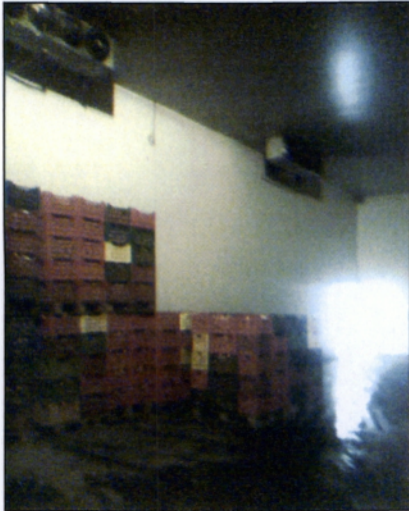
Φωτογραφία 22: Θάλαμος για συντήρηση καρπών με τουρμπίνες που ψύχουν την ατμόσφαιρα
