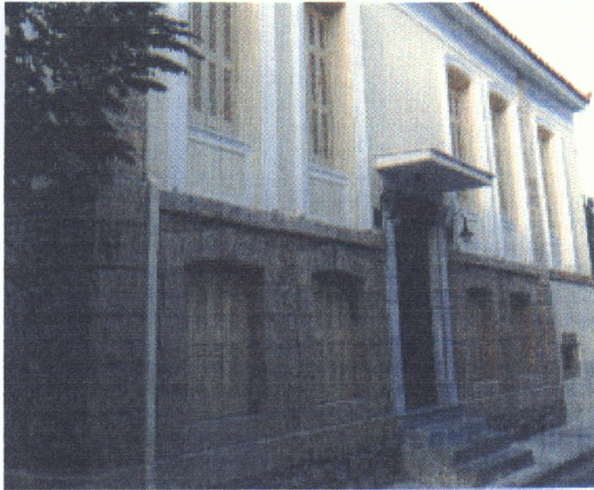
Φωτ. 17: Κτήριο ΔΕΠΑΚ
