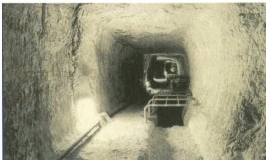
Εικόνα 13: εσωτερικό μέρος της σήραγγας
