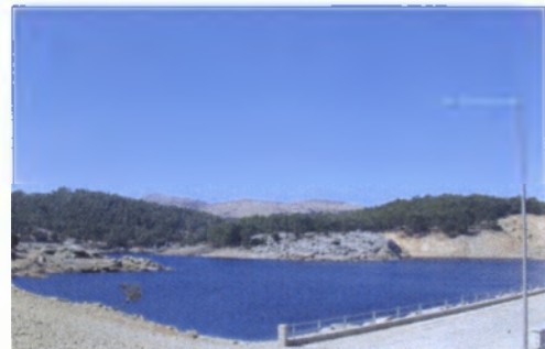
Εικόνα 41: φράγμα Πεζίου Ραχών Ικαρίας http://www.archipelago.gr/el/Home/PhotoGallery/tabid/186/xmmid/559/xmid/4
