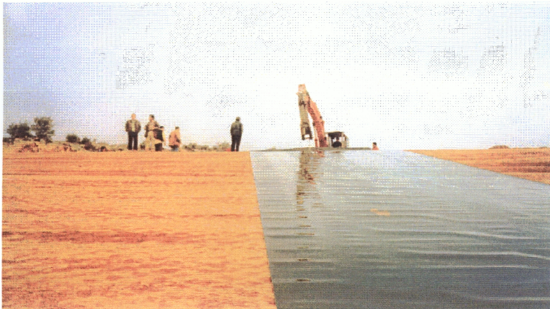
Εικόνα. 6 Τοποθέτηση Εγκατάσταση Γεωμεμβρανών
