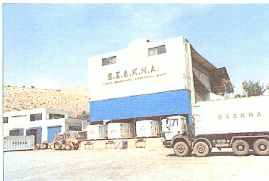
ΕΙΚΟΝΑ.10 Σταθμός Μεταφόρτωσης Απορριμμάτων.
