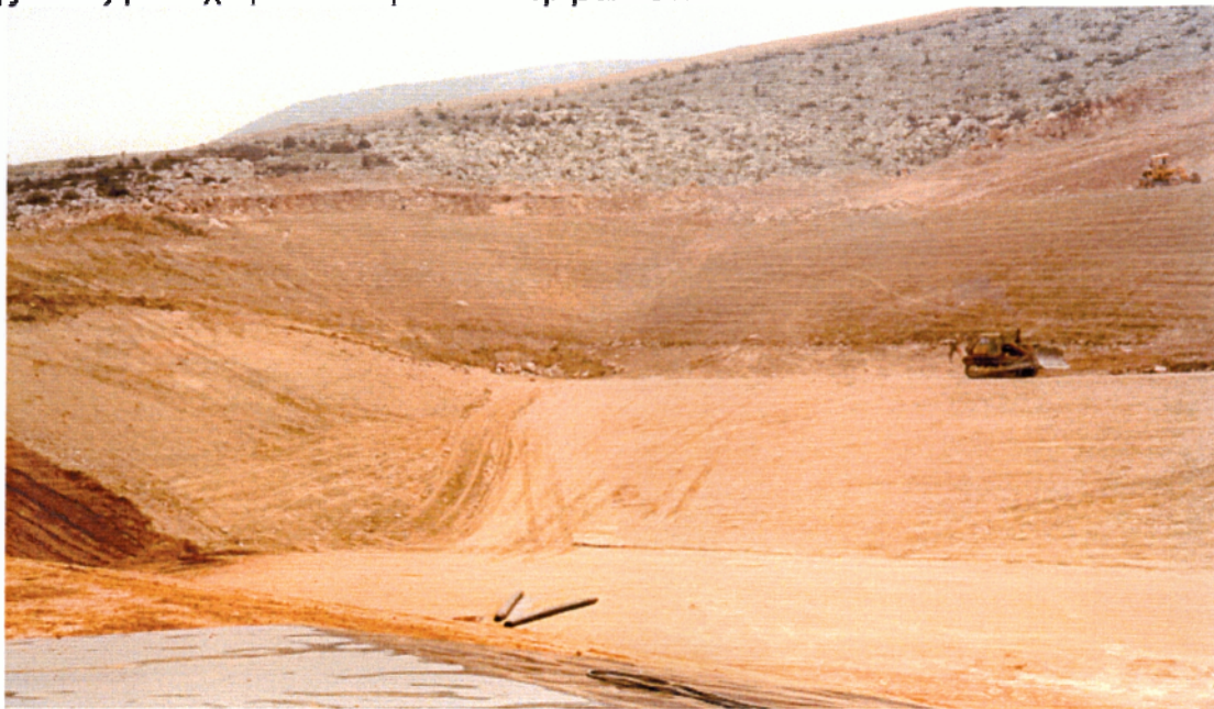
ΕΙΚΟΝΑ 3. Διαμόρφωση του πυθμένα και των πρανών στον Χ.Υ.Τ.Α. Άνω Λιοσίων
