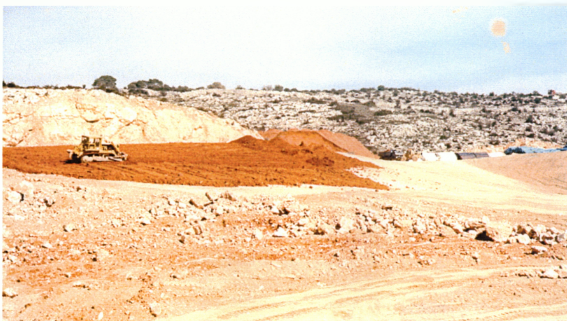
Εικόνα .8 Διάστρωσης του αργιλικού φραγμού στον πυθμένα
