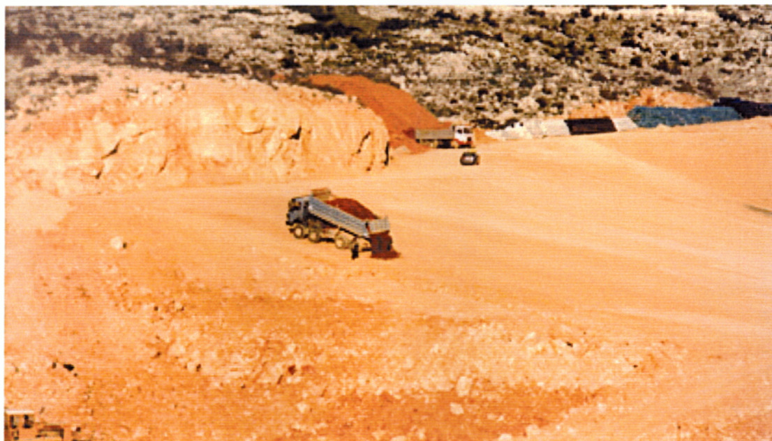
Εικόνα 4. Η διάσπρωση αργιλικού υλικού στον πυθμένα του Χ.Υ.Τ.Α. Άνω Λιοσίων
