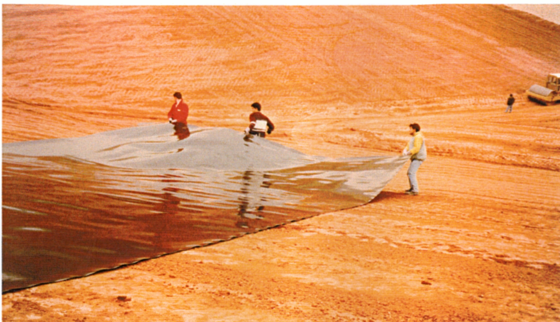
Εικόνα 5. Τοποθέτηση Εγκατάσταση Γεωμεμβρανών
