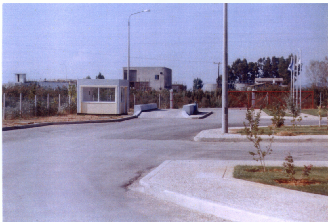
Περιβάλλον χώρος της μονάδας - Γεφυροπλάστιγγα
