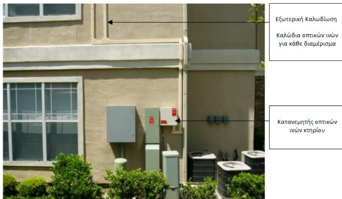
(σχ. 5.13) Παράδειγμα οπτική εσωτερικής σύνδεσης σε FTTH [50]
