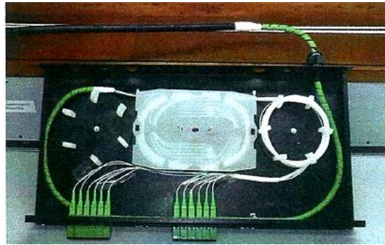
Εικόνα 38: Κατανομητής Οριζόντιας Τεχνικής
