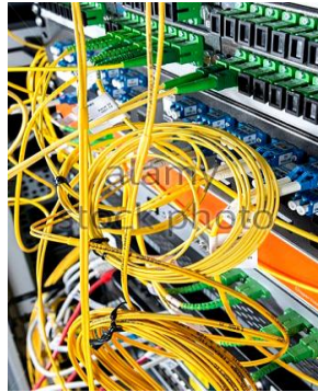
Εικόνα 41: Μεικτονόμηση με rig-tails σε Οπτικούς Κατανεμητές.
