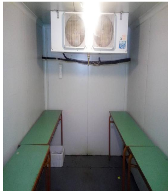
Εικόνες 21 & 22: Άποψη εξωτερική και εσωτερική του ψυκτικού θαλάμου συντήρησης τύπου FRIGA-BOHN.
