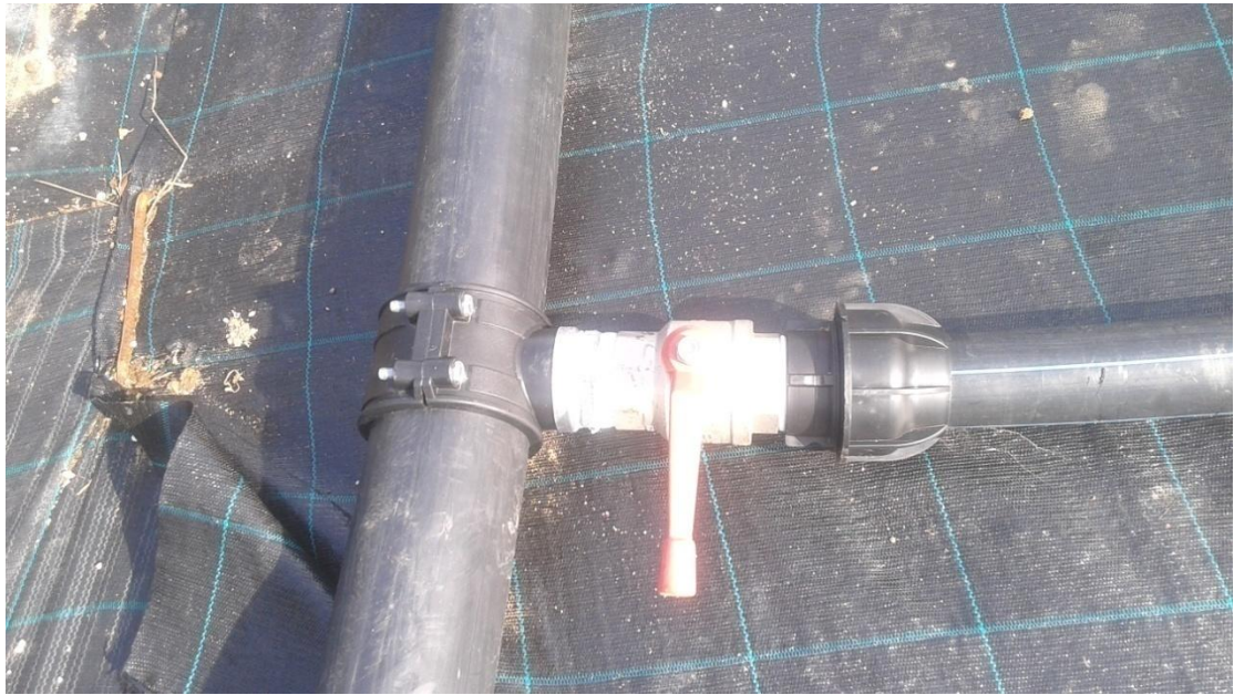
Συνδεσμολογία σωλήνων Ø110 με Ø63
