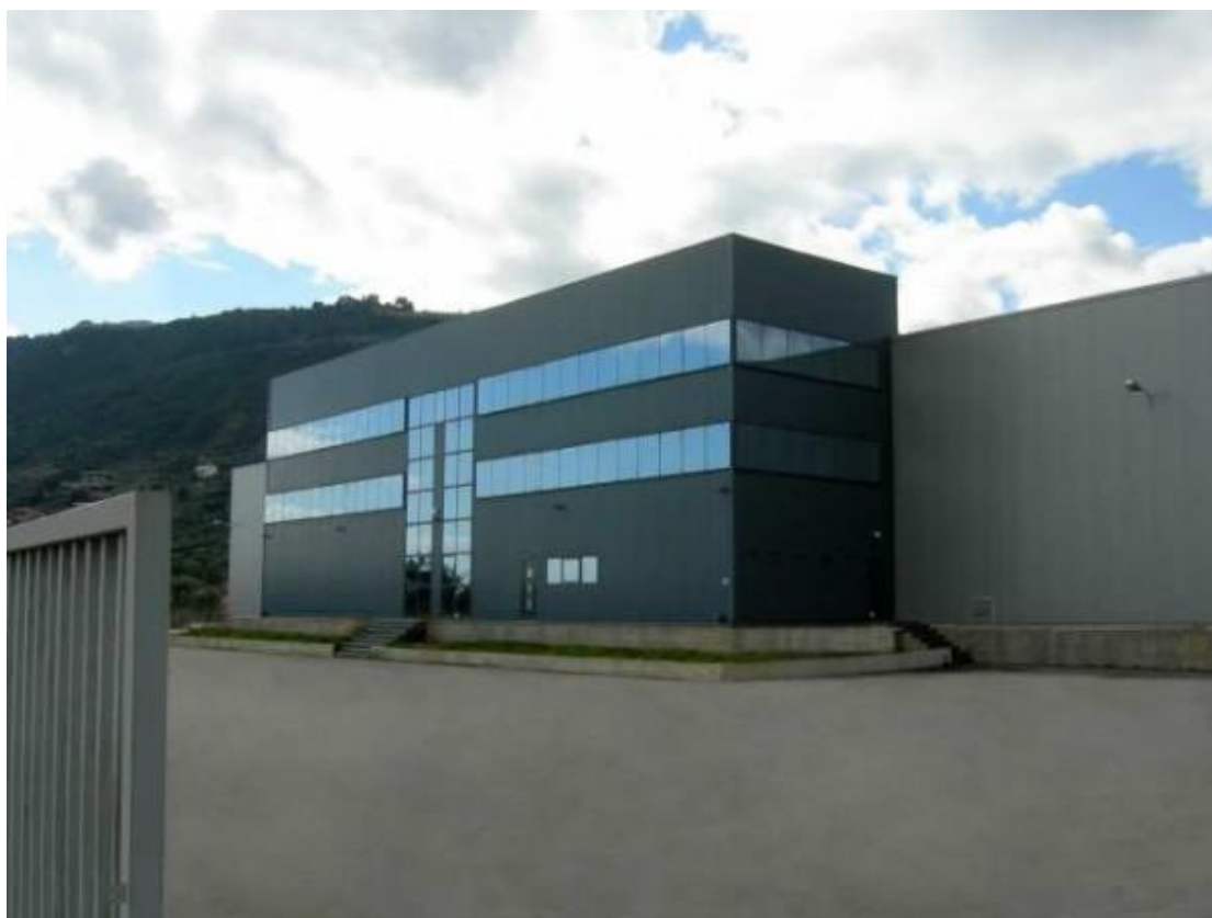
Εικόνα 7 η : Τρίτη μονάδα : Εργοστάσιο παραγωγής συσκευασιών, Αίγιο
